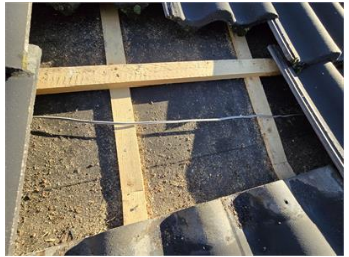
Tak: Stickprovskontroll under pannor, tunna ströläkt.
