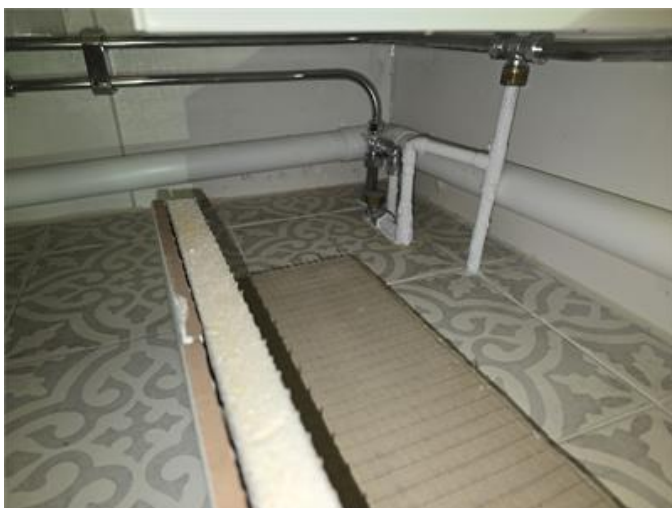
Exempel på rör genomföringar i golv.
