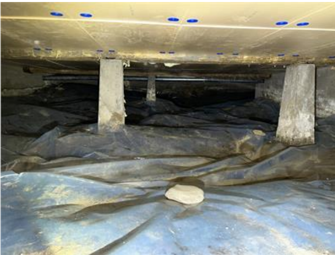
Krypgrund mitten: Översiktsbild med notering fritt stående vatten.
