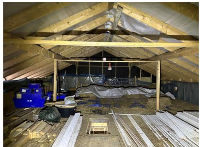
Garage nockvind: Översiktsbild.
