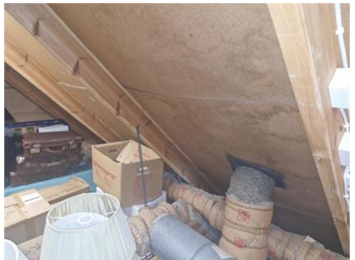
Nockvind, torra fuktanvisningar på undertaksskivorna.
