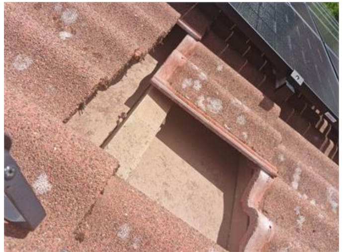
Tak, underlagstak av träfiberskivor.
