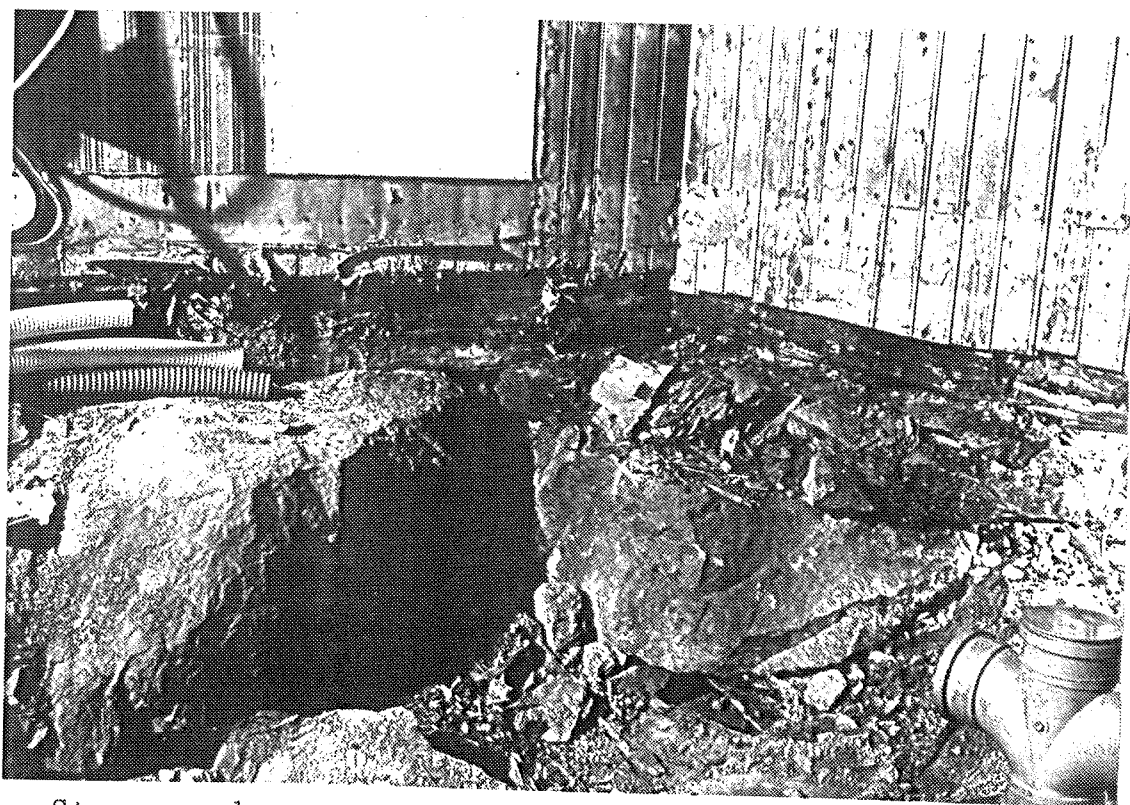
Stora gundstenar under knuten, SV hörnet gamla köket. Hörnen är de viktigaste punkterna i det knuttimrade husets grundläggning, då det är här merparten av lasten tas ner.
