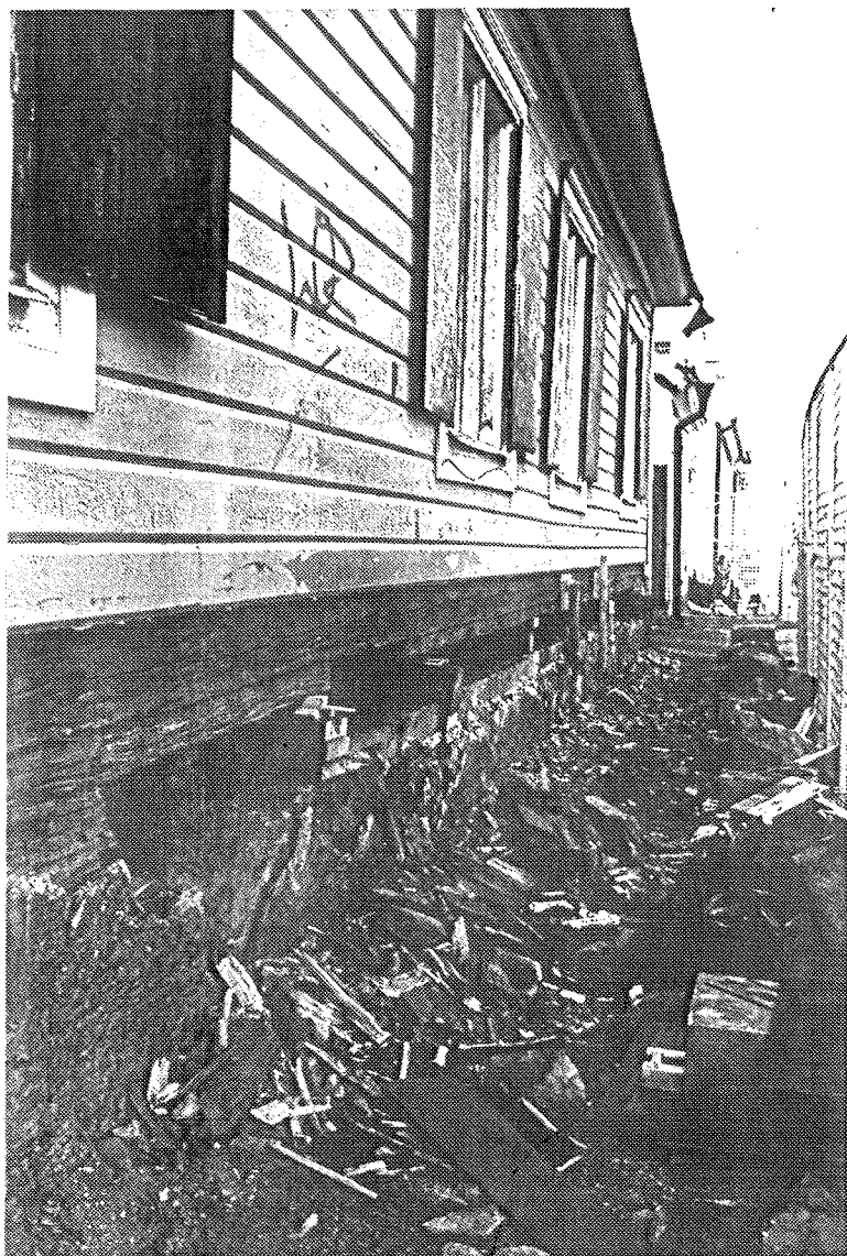
Gatufasaden sedan den gamla rötade syllstocken rivits ut. Stensockeln avjämnades med betong i överkant och mot insidan.
