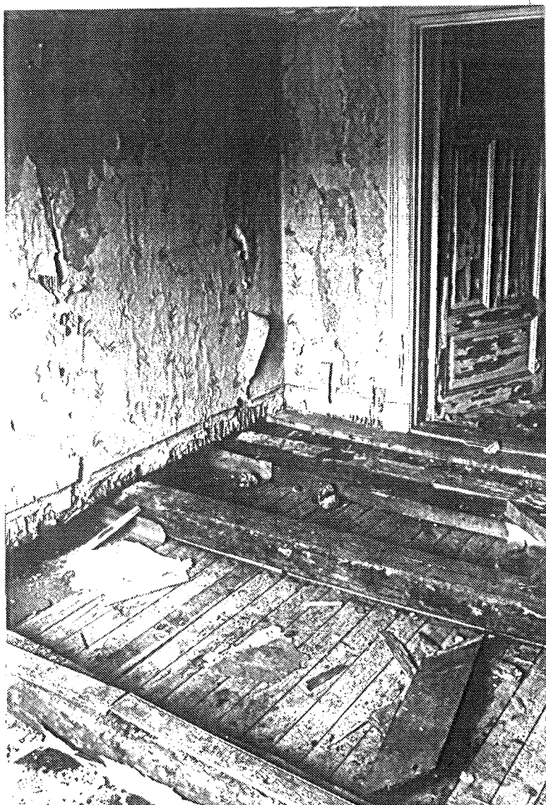
Rum 212 fd sovrum, blivande bad i övervåningen. Golvet demonterat och bjälklagsfyllningen utriven.
