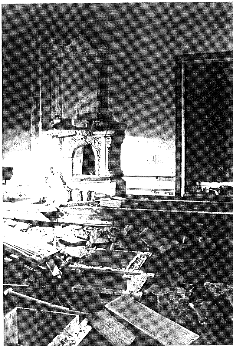
Salens kakelugn på egen grundläggning Två gamla bjälkar framför ugnen. I för- grunden syns en nygjuten stämpklack med gjutformen kvar.
