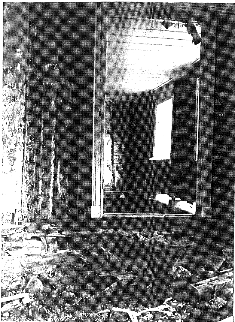
Mellanväggssyll mellan 208 & 207 stämplad under dörrhålet av en stor natursten. Obs väggskivan av resvirke mellan muren och dörrhålet (t.v)
