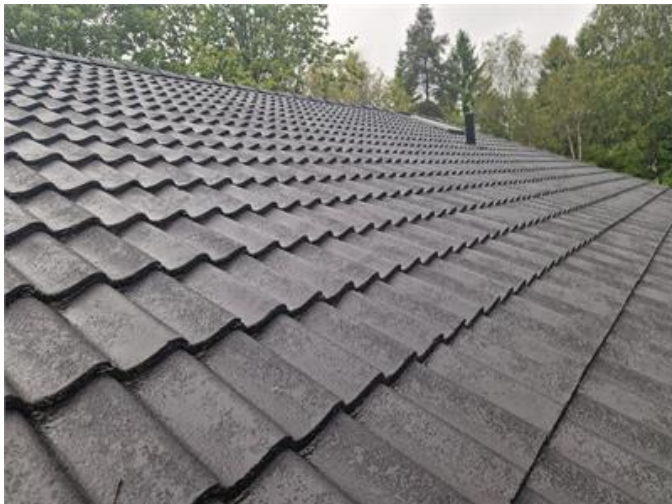
Vy på yttertak
