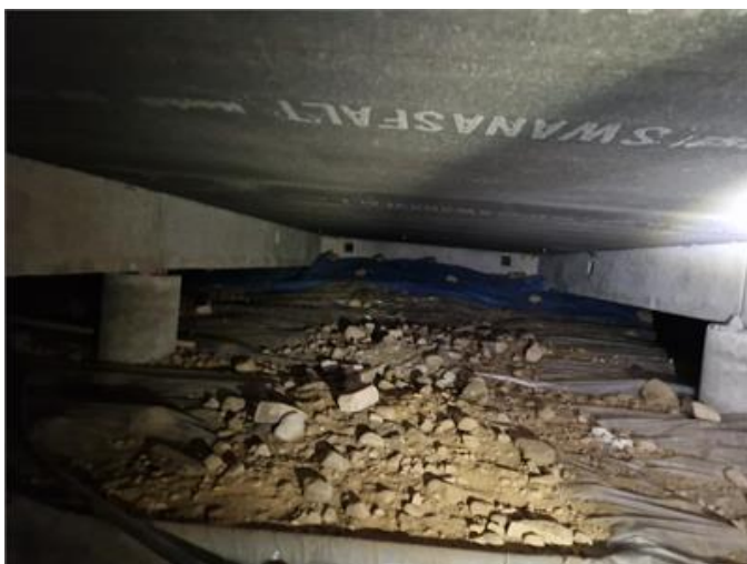
Vy i krypgrund
