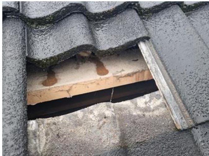
Vy på underlagstak med fuktkänslig avslutning
