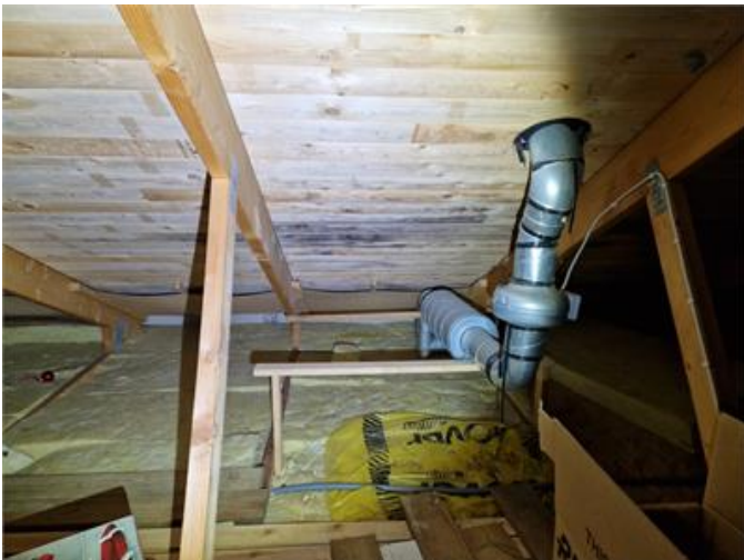
Vind: Mikrobiell påväxt förekommer lokalt i underlagstak.
