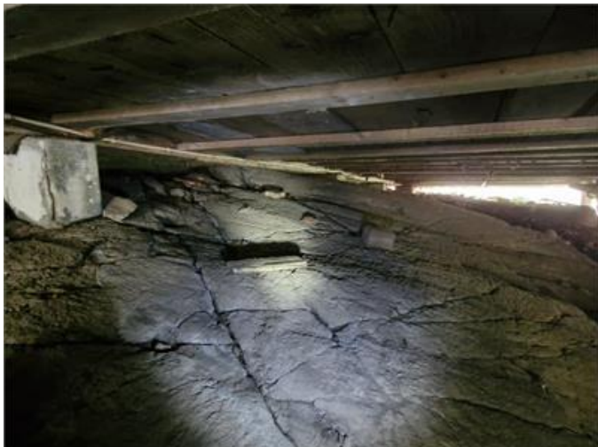
Plintgrund, översiktsbild östra delen.
