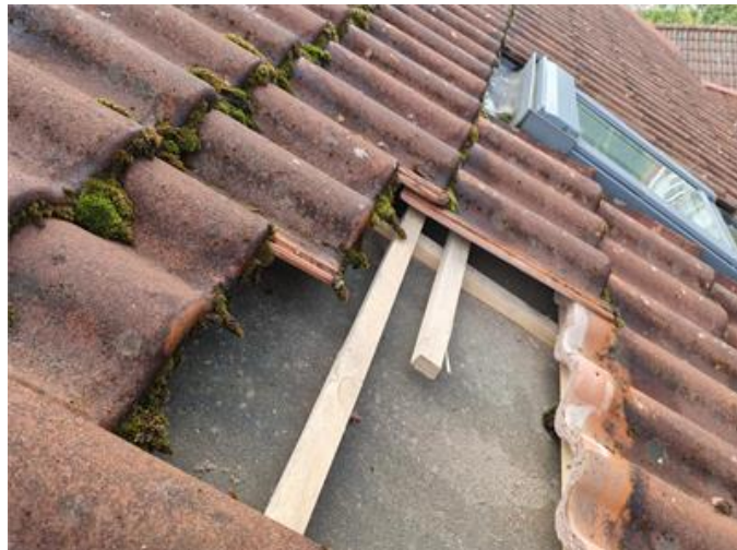
Tak norra sidan, kontroll under pannorna.
