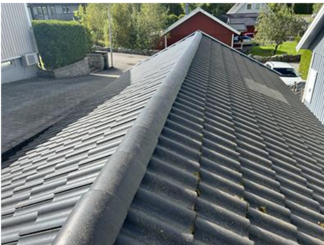
Garage tak: Översiktsbild.
