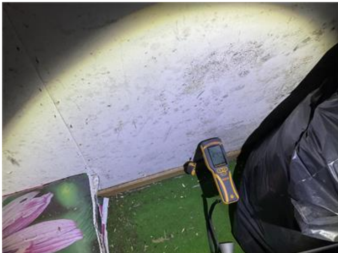
Fuktmätning i garagevägg.
