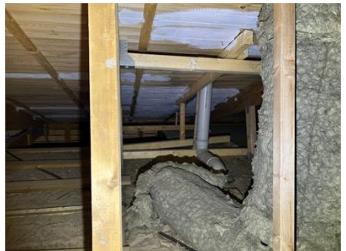
Nockvind: Målat underlagstaket vid nordvästsidan, oklar anledning.
