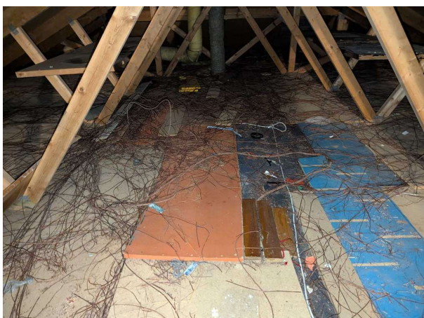
Bild 5: Utvändigt, Fasad, Den ymniga växtligheten har trängt in i stora delar av tak och bjälklag.
