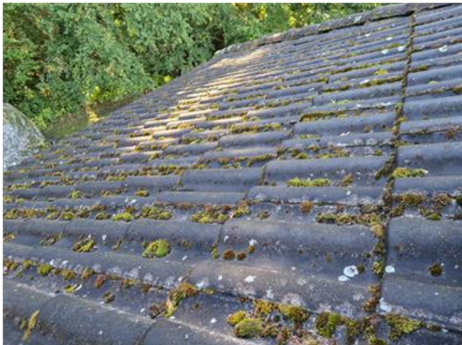
Vy på yttertak
