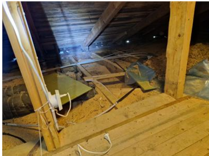
Vy på underlagstak
