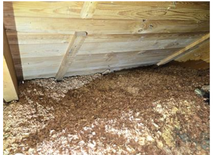
Nockvind: Luftspalter delvis täckta med isolering.
