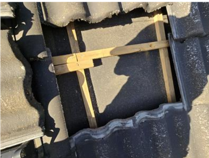
Tak: Stickprovskontroll under pannor utan anmärkning.
