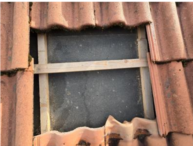
Tak: Stickprovskontroll under pannor utan anmärkning.
