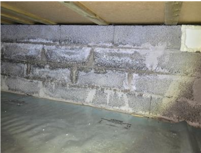
Krypgrund: Översiktsbild norra sidan.
