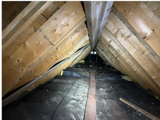
Bilden visar del av vindsutrymmet.
