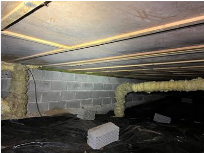
Bilden visar del av krypgrunden.
