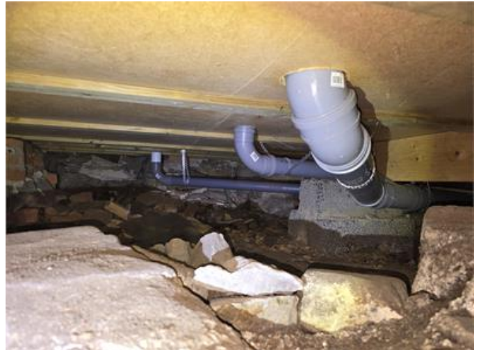
Krypgrund: Översiktsbild under Dusch/Wc.
