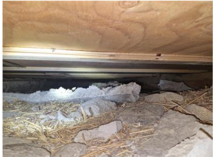
Grundläggning söder träbjälklag ovan grovkällaren.
