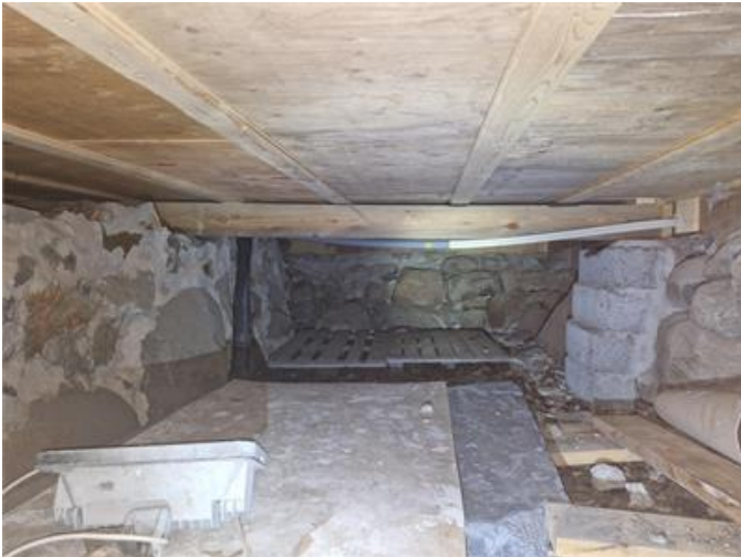
Grundläggning översiktsbild mittre delen. Vänster i bild träbjälklag ovan grovkällaren. Höger i bild betonggjutning.
