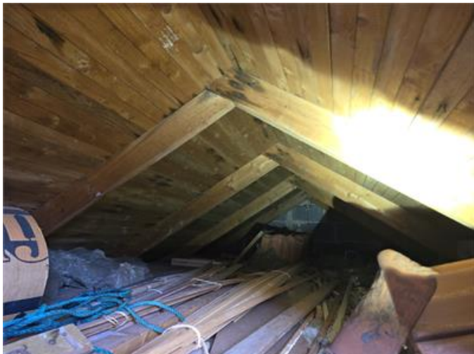
Bilden visar del av vindsutrymmet.
