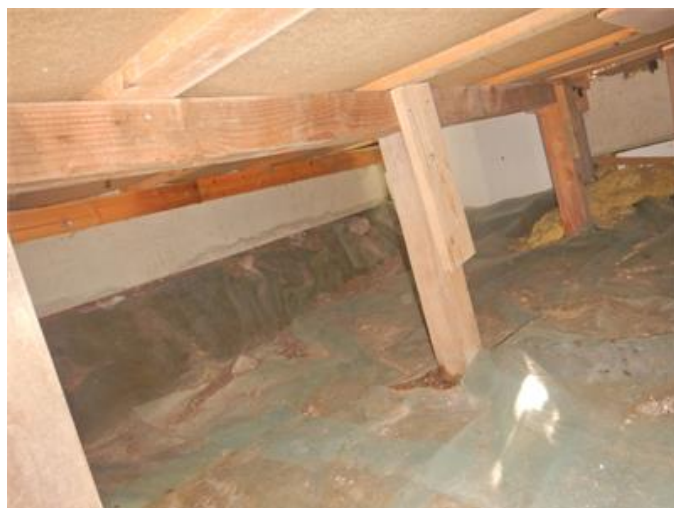
Enklare uppstaging av bjälklag under förråd/klädvård
