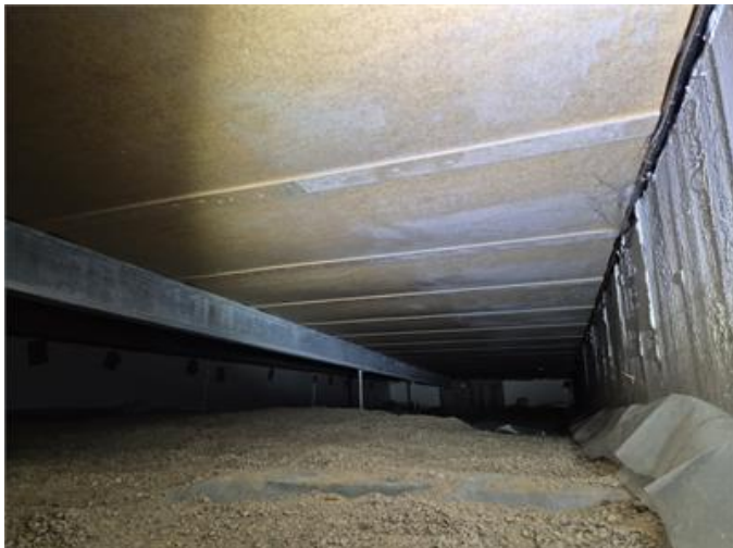
Bild från krypgrunden
