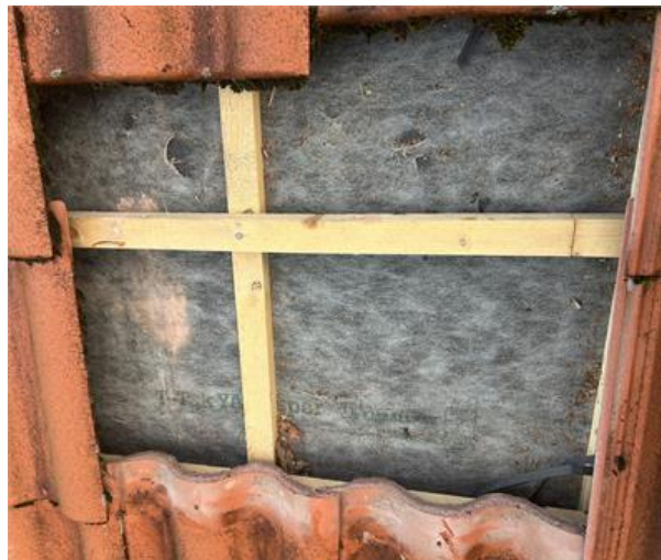
Tak: Stickkontroll under betongpannor.
