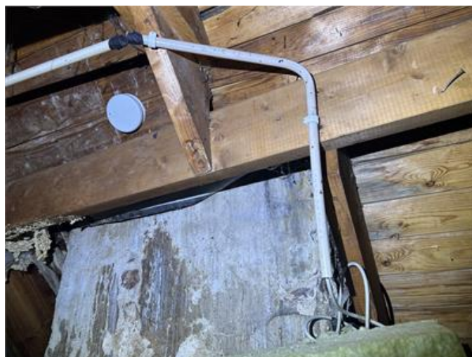
Nockvind: Fuktanvisning vid bl.a. murstocken.
