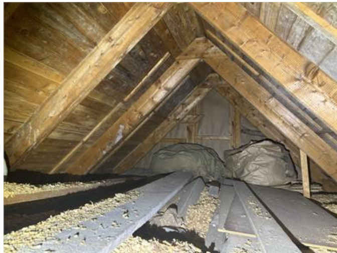
Nockvind öst: Översiktsbild.
