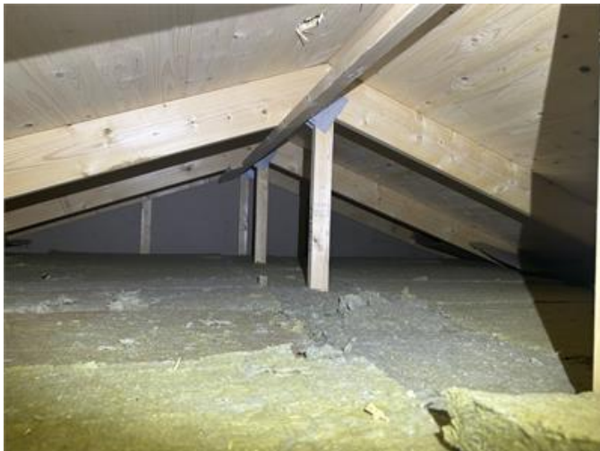
Nockvind tillbyggnad: Översiktsbild.
