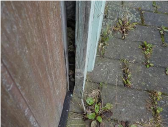
Garaget: Större öppning mellan dörrpartiet och fasaden.
