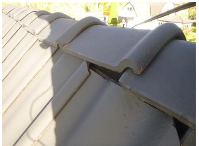
Nockpannor delvis i behov av justering
