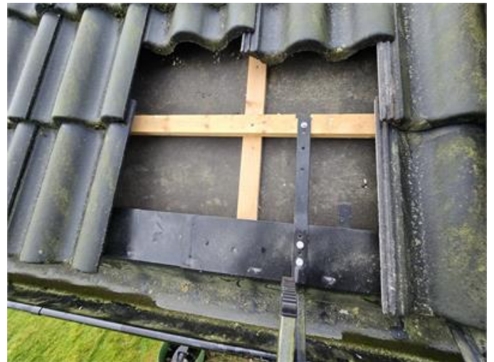
Tak: Stickprovskontroll under pannor.
