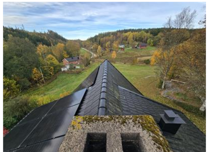
Tak: Översiktsbild mot väster.
