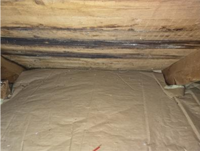
Nockvind: Isolering som ligger an mot underlagstak.
