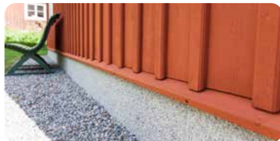
Offerlist i nederkant av yttervägg mot grund.
