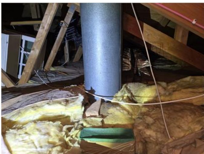
Nockvind: Kanal i anslutning till skorsten som avslutas i utrymmet.
