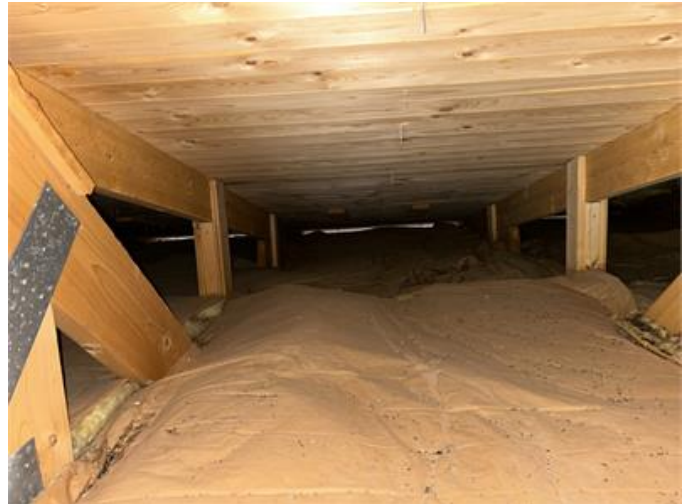
Vind ovan veranda: Översiktsbild från luckan
