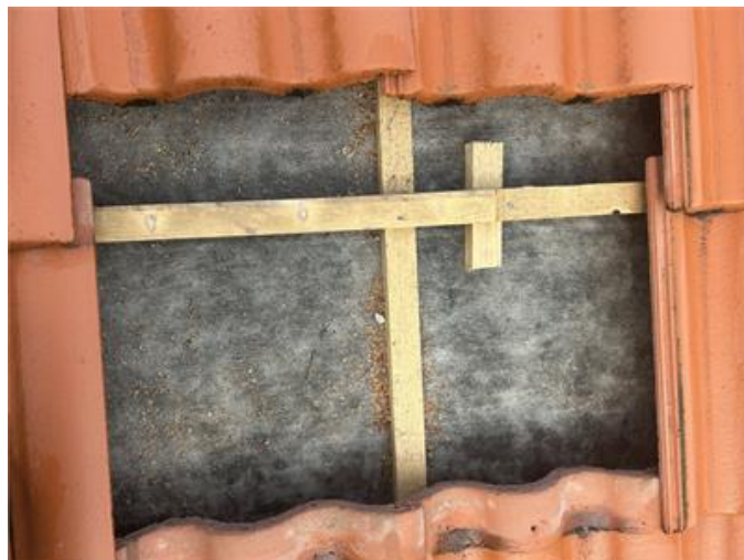
Tak: Stickkontroll under betongpannor.
