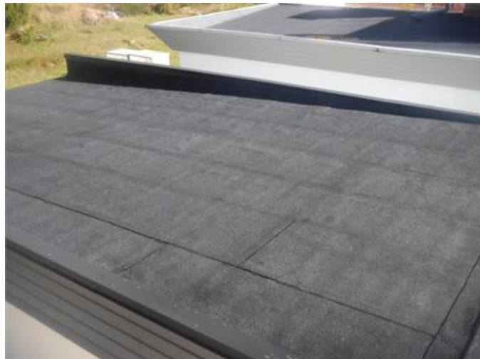
Tak/garage: Taket är låglutande och klätt med takpapp. Taket är äldre (från husets ursprung) och är enligt bedömning i behov av byte/renovering. Ta kontakt med fackman för vidare bedömning.
