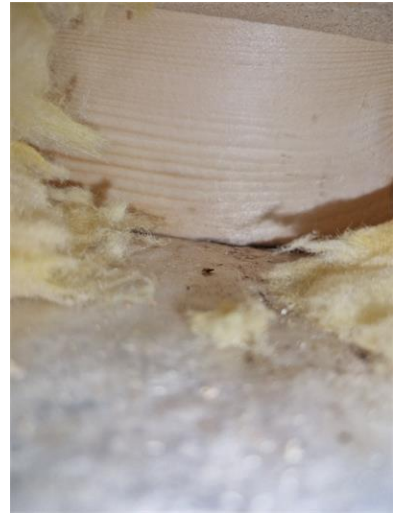
Bild på golvregel från kontroll av konstruktion.
