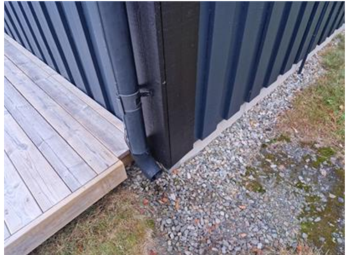
Fasad och takavvattning.
