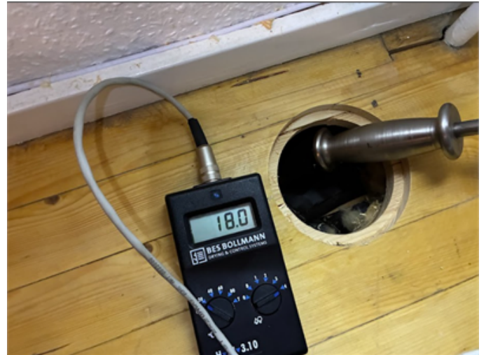
Bilden visar fuktkvotsmätning i golv i kloss på underliggande betonggol.
