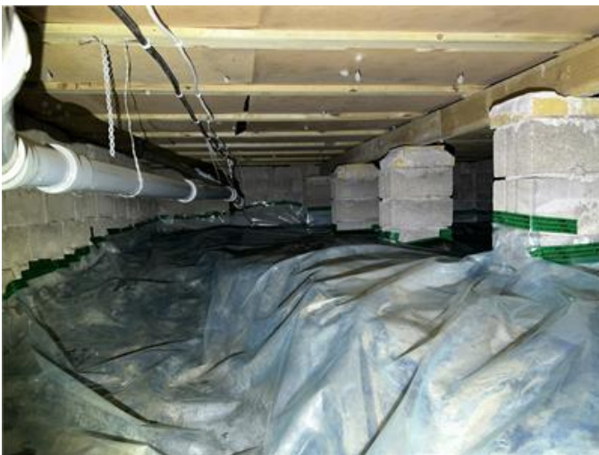
Krypgrund väster: Översiktsbild.
