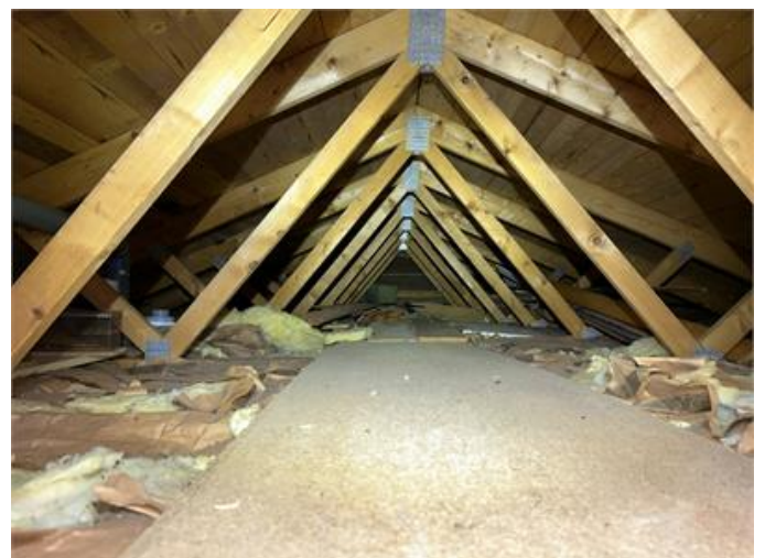
Nockvind väst: Översiktsbild.
