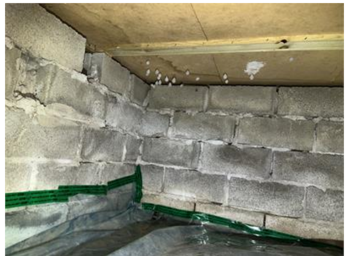
Krypgrund väster: Fuktanvisningar på trossbottensskivor, torra vid besiktningstillfället.
