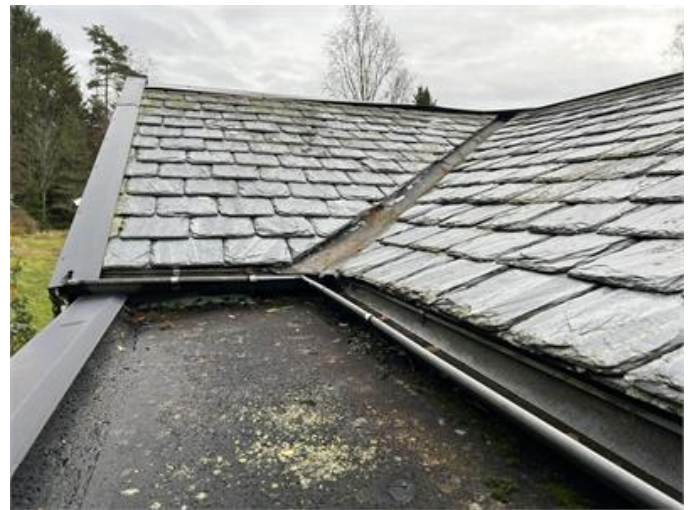
Tak: Papptak med mycket skräp samt rostangripna plåtdetaljer
