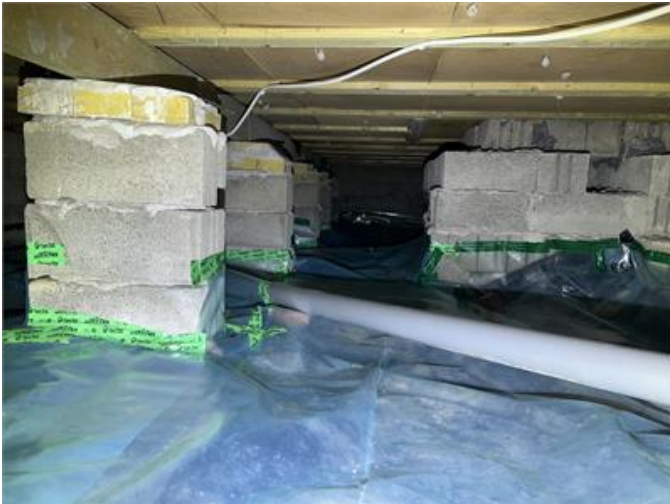
Krypgrund öster: Översiktsbild.
