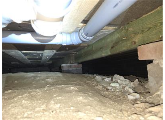
Krypgrund: Översiktsbild mot söder, rötskyddsbehandlat virke noteras.
