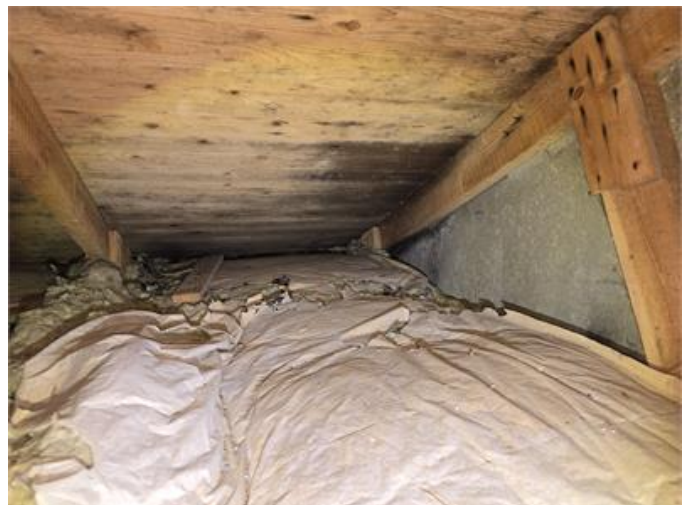
Nockvind: Mikrobiell påväxt/missfärgningar på underlagstak, eternitskivor på gavel.
