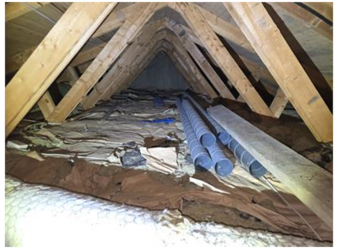
Nockvind: Översiktsbild från norr.
