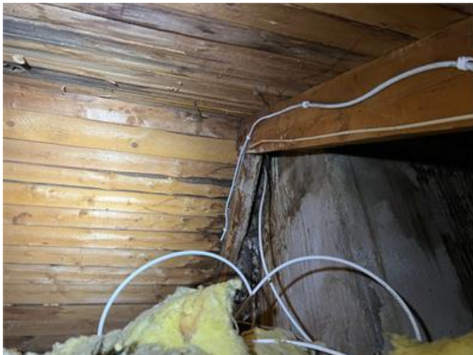
Bilden visar del av underlagstaket i vindsutrymmet.
