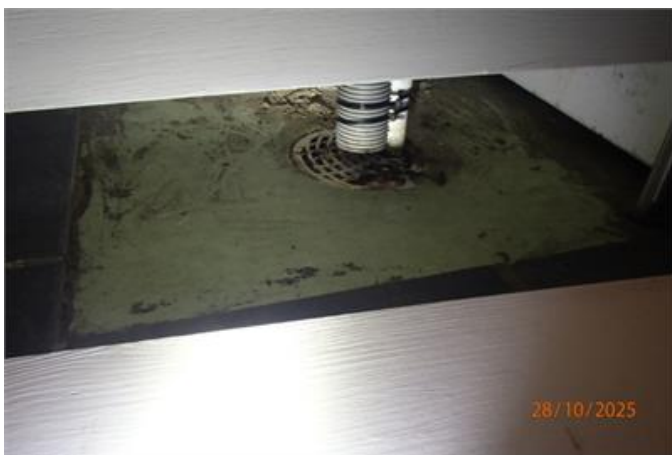
Klinker monterat på befintlig plastmatta i tvätttrummet.
