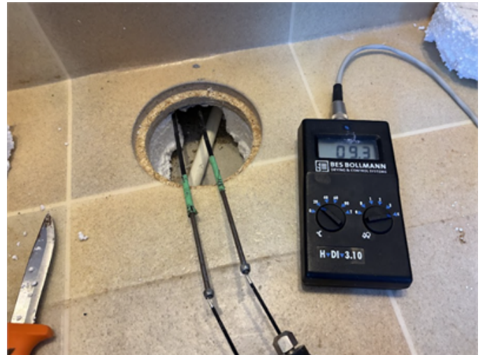
Bilden visar kontroll av golvkonstruktion samt fuktkvotsmätning i innerväggsyll. Gränsvärde är 17%FK.
