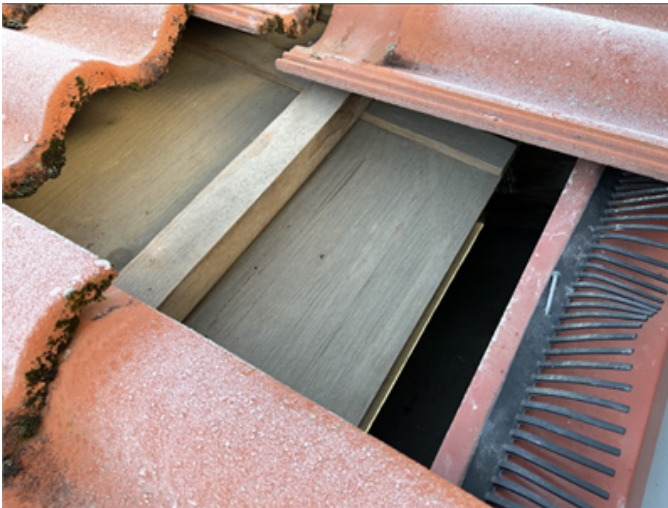
Tak: Underlagstaket består av träfiberskivor utan yttre täckning av papp. Pannor är ej spikade runtom.
