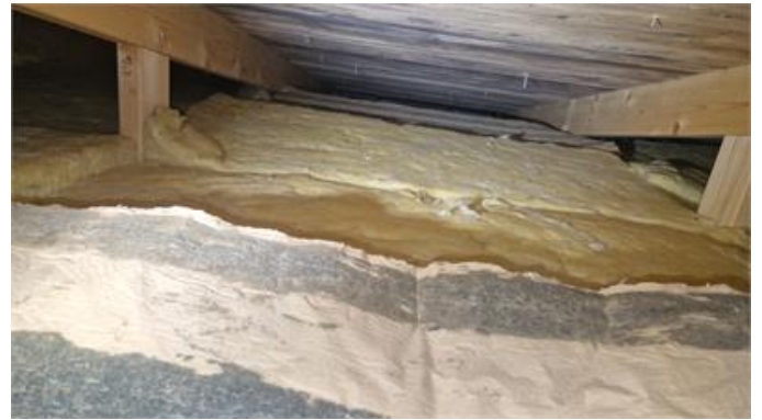
Bild på delar av vinden ovan tillbyggnad
