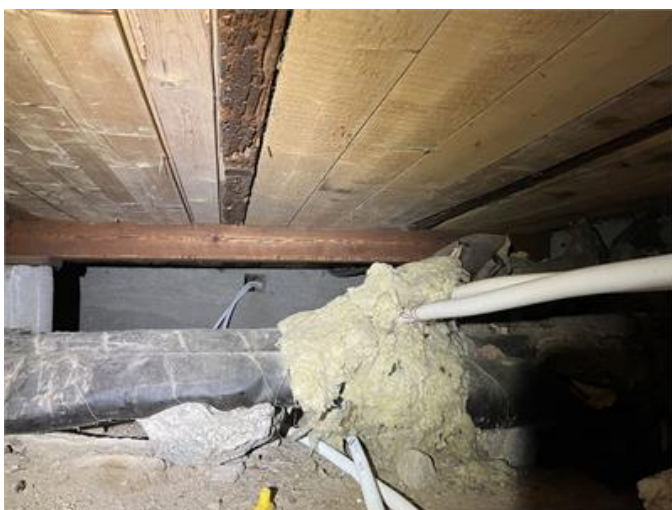
Bild från krypgrunden där man ser en nyare regel dikt an äldre rötskadad regel.
