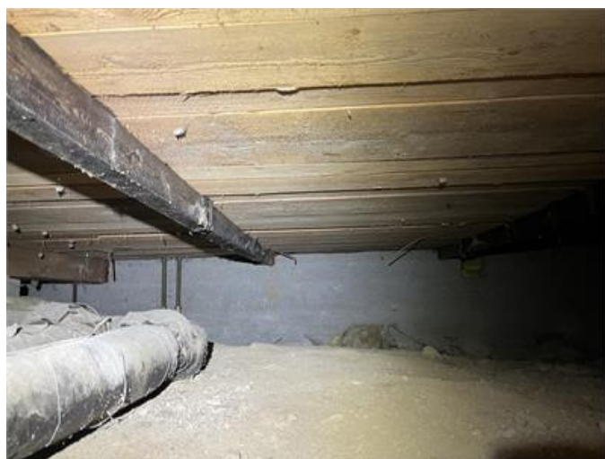
Bild från del av krypgrunden.
