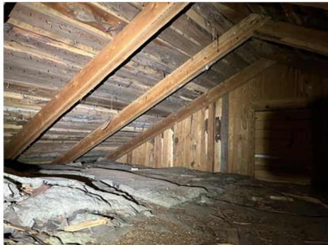
Bilden visar del av vinden.
