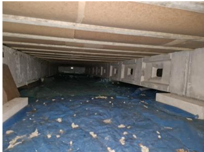
Vy i krypgrund
