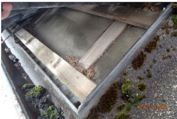
Underlagspapp i takfot på huset
