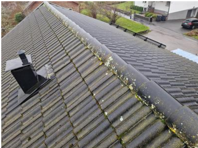
Vy på yttertak
