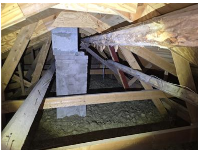
Nockvind: Översiktsbild över äldre del mot öst.
