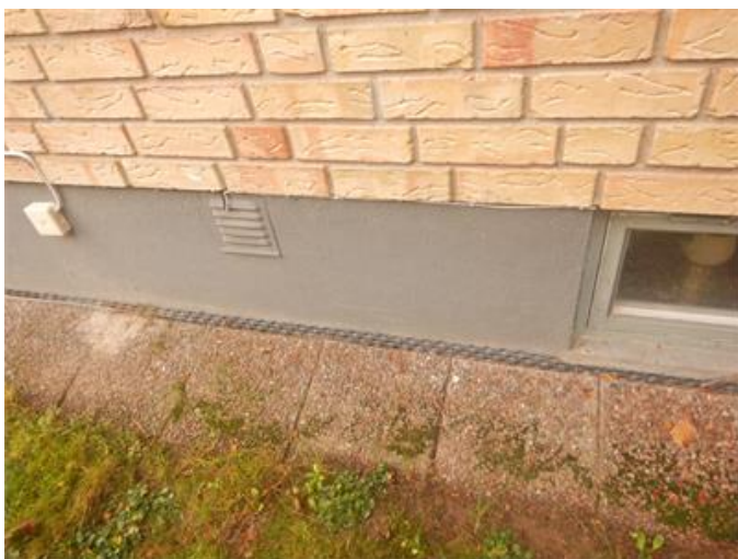
Synlig kant av utvändigt fuktskydd.
