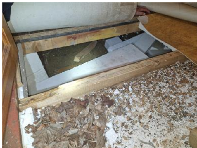
Entredel Krypgrund, bild vid luckan.
