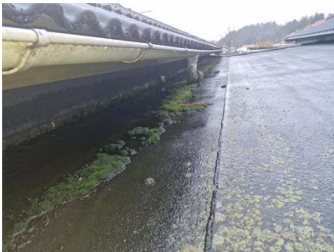
Tak Entredel, låglutande med stående vatten och mossor. Tak Ursprunglig del, översiktsbild.
