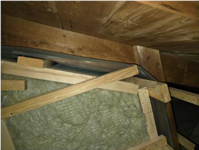
Bilden visar exempel på vägg mot inred vind sett från kallvinden.
