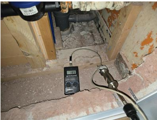
Fuktmätning i innerväggssyll via lucka från tv-rum.
