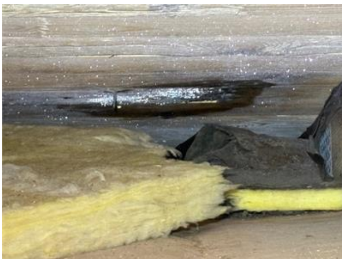
Bilden visar inläckage/missfärgning på vinden.
