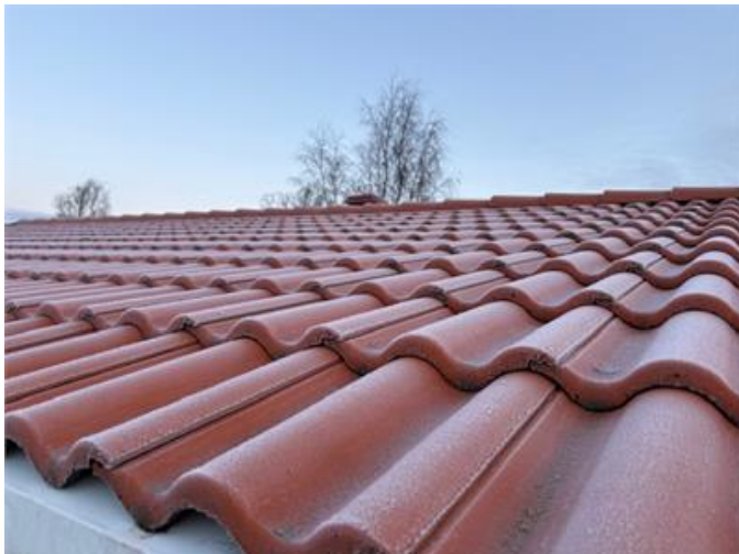
Bilden visar vy av tak (huvudbyggnad).
