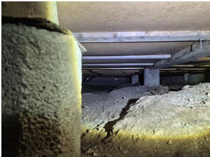
Bild från krypgrund under 1-plansdelen
